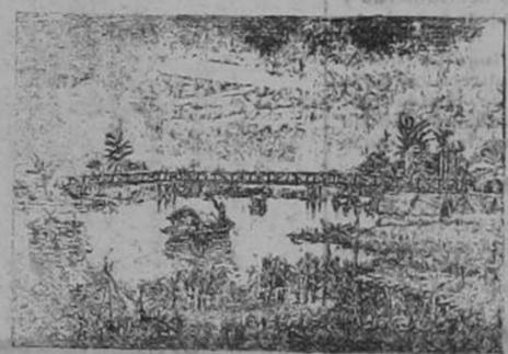
PUENTE DE 66 METROS EN DONG-NHYEN (Conchinchina) compuesto de 3 puentes de 22 metros, tipo 6 bis. Datos generales de un puente de 22 metros: Anchura disponible 3 mts. Carga por metro cuadrado 300 k. Largo mínimo que se contruyó 900 k. Carga por metro lineal 900 k. Carga total máxima 19800 k. Peso del elemento más pesado 162 k. Carga rodante máxima 6000 k. Largo del elemento más grande 6 m. LUCIANO ROJAS, apartado 484, Agente general en Costa Rica.
